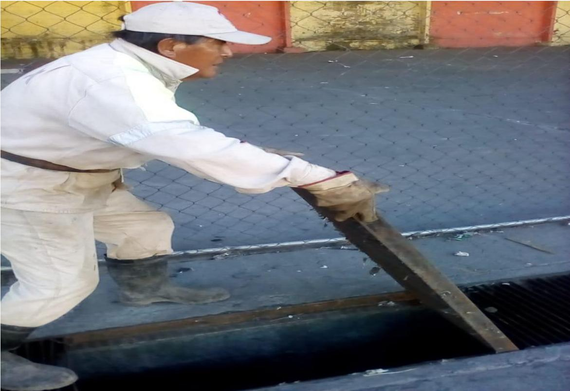
*Ilustración 14. Desazolve de las alcantarillas en el patio del ex módulo 46, para evitar inundaciones en el Archivo de Concentración.*
